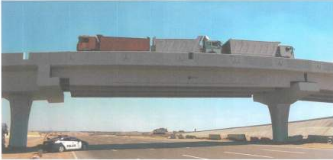
شكل رقم (٥-١): النظام الإنشائي للباكية المختبرة
