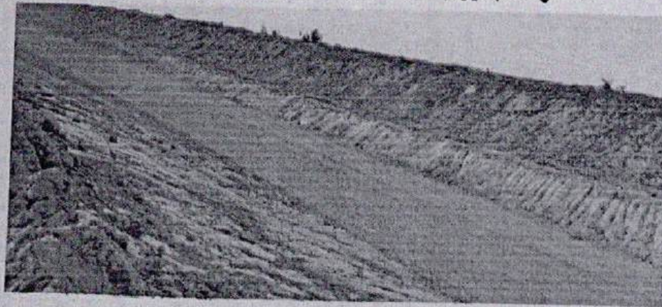
المصارف بعد التطهير والالتزام بالميل ٣:١ و عمل فلتر طبقا لتعليمات سيسترا
